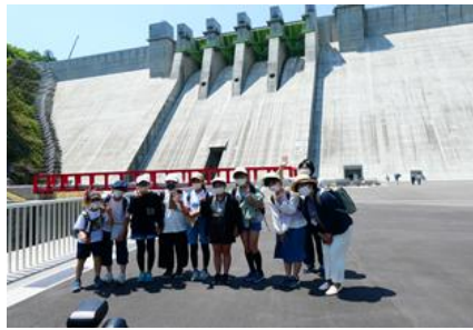
ハッ場ダム下からの堰堤
